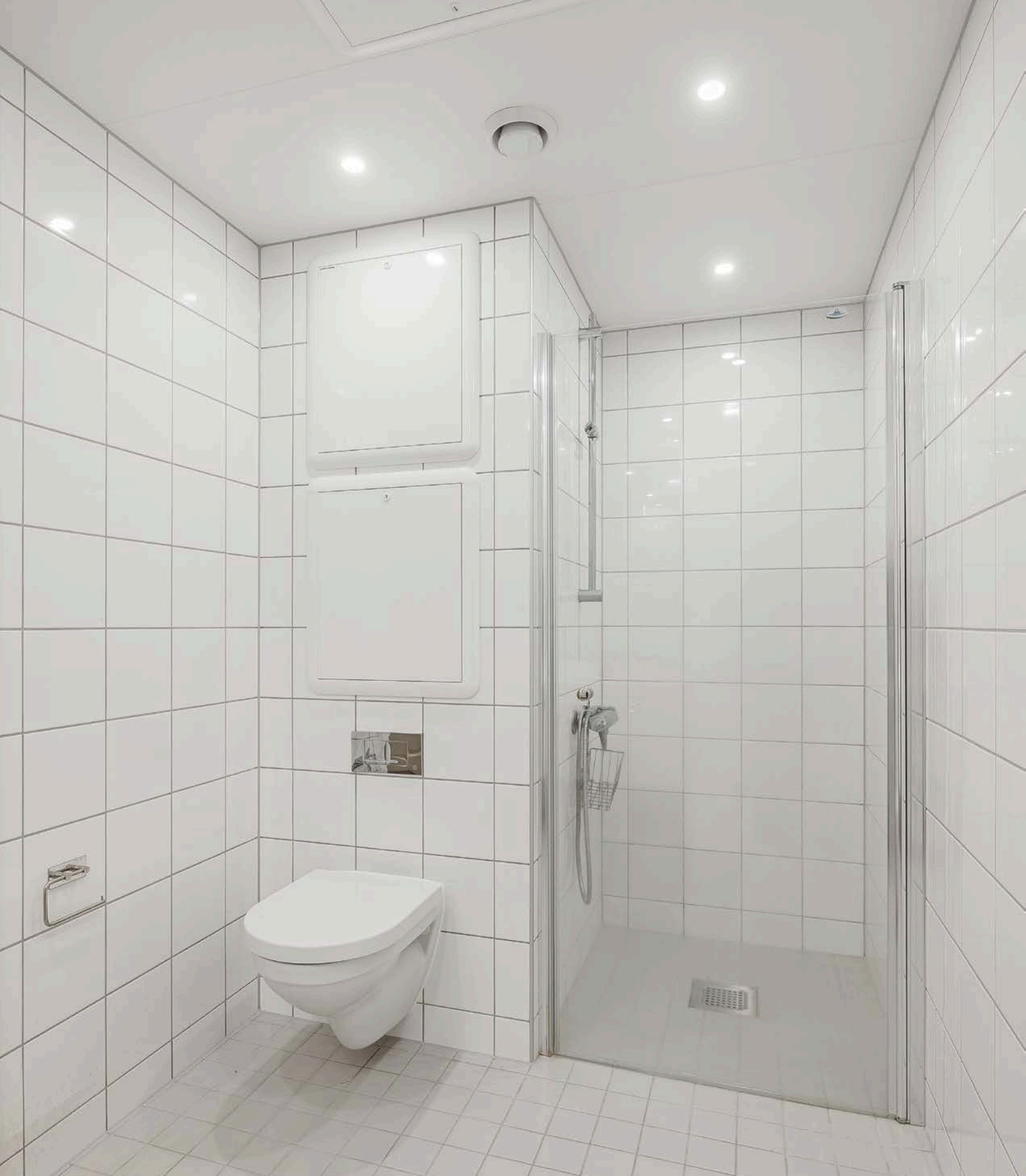
Baderommet er utstyrt med baderomsinnredning med heldekkende servant og stort speil over, dusjnise med glassdør og vegghengt toalett.
