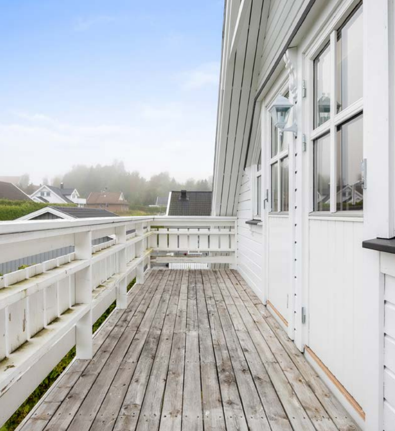
Fra to av soverommene i andre etasje er det utgang til veranda. Denne har fin plass til enkelt utemøblement.
