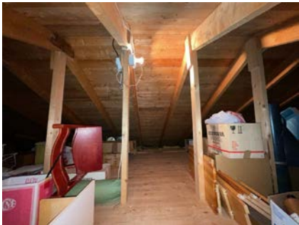
Kaldloft med tro for for lagring.
