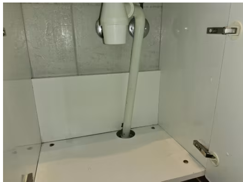
Leiligheten har synlige avløpsrør av plast.
