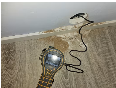
Bilde fra fuktmåling i veggkonstruksjon.
