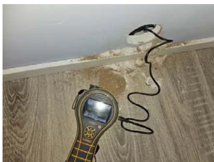
Bilde fra fuktmåling i veggkonstruksjon.
