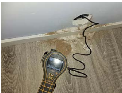
Bilde fra fuktmåling i veggkonstruksjon.
