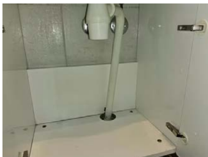
Leiligheten har synlige avløpsrør av plast.
