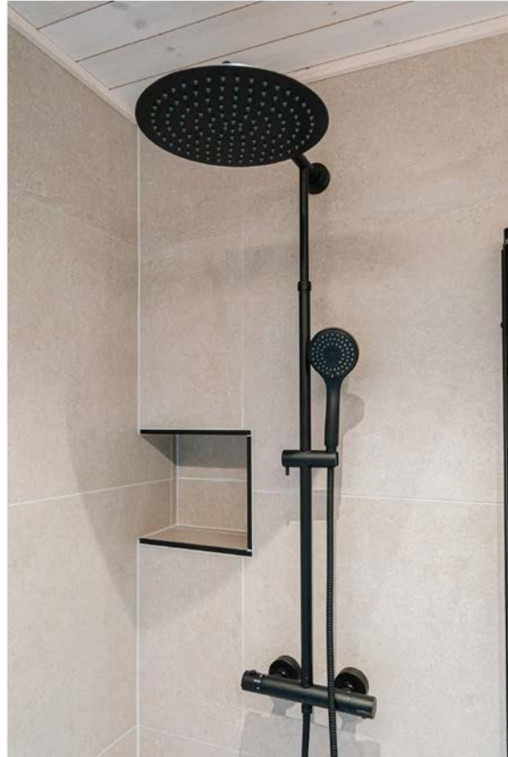
Det er dusjhjørne i klart glass, med regndusj og veggisje, samt vegghengt toalett.
