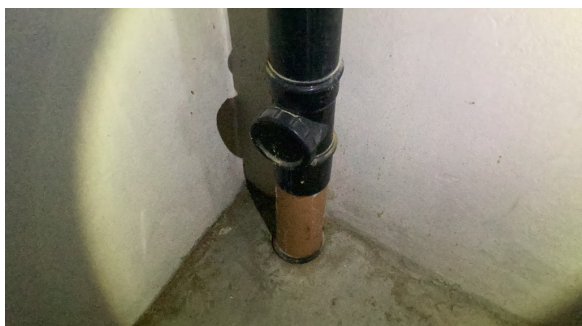
Stakepunkt i kjeller.
