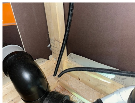
Overlapp mellom gulvbelegg og veggplater.
