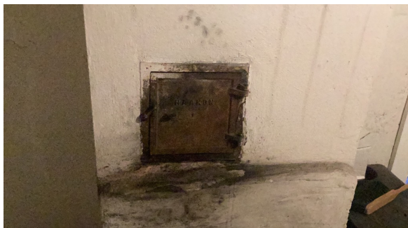
Sotluke i kjeller.
