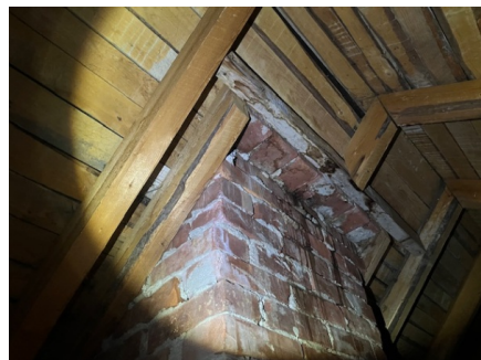
Noen fuktmerker rundt pipe. Mangel på murpuss på pipe på loft kan medføre avvik ved et eventuelt branntilsyn.
