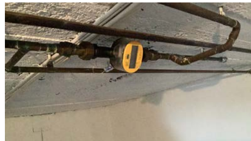
Vannmåler i kjeller.
