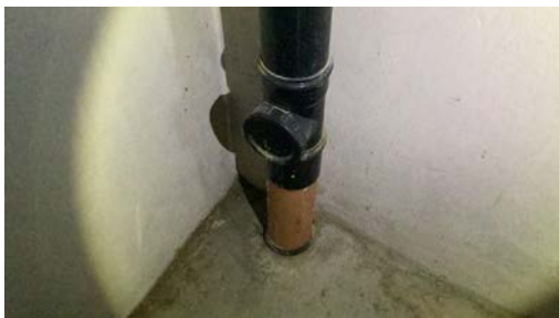
Stakepunkt i kjeller.
