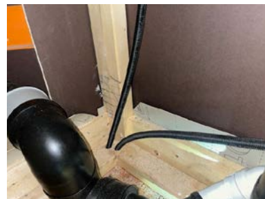
Overlapp mellom gulvbelegg og veggplater.
