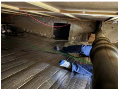
Viser avløpsrør i krypkjeller
