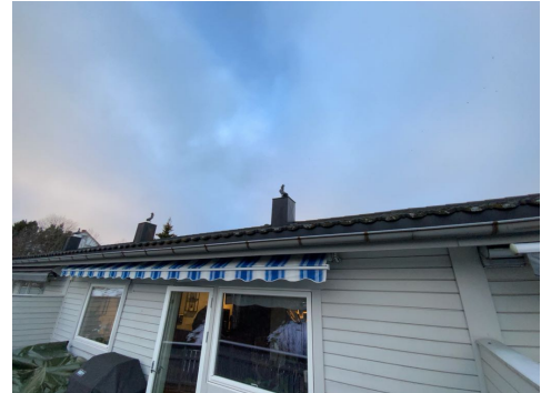
Besiktigelse av taktekke.
