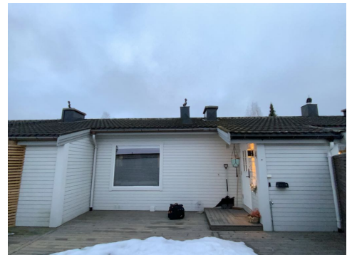
Besiktigelse av taktekke.
