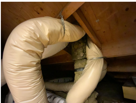
Kontroll rundt rørgjennomføringer.
