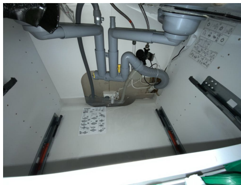
Besiktigelse av røropplegg.
