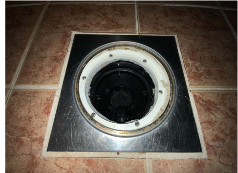
Kontroll av sluk.
