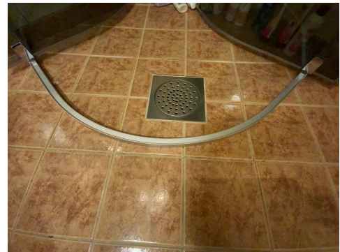
Tilrenning til sluk gjennom bunnskinne bør opparbeides.
