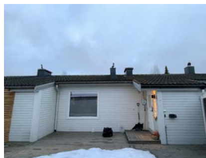
Besiktigelse av taktekke.
