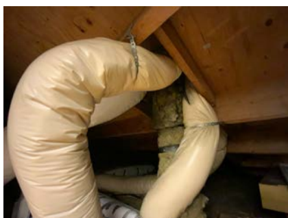
Kontroll rundt rørgjennomføringer.
