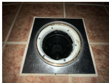
Kontroll av sluk.
