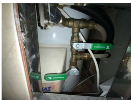
Besiktigelse av bereder.
