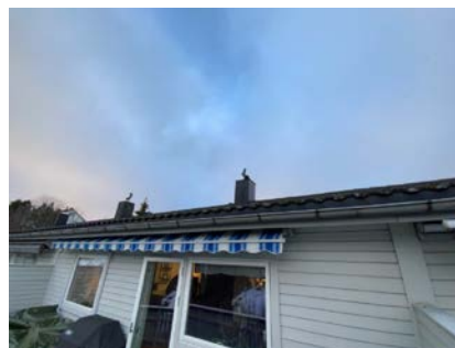
Besiktigelse av taktekke.
