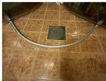
Tilrenning til sluk gjennom bunnskinne bør opparbeides.
