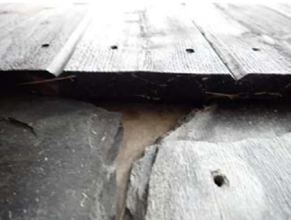
Oversikt oppunder trekledning.
