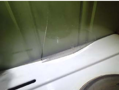
Skade i plasplate.
