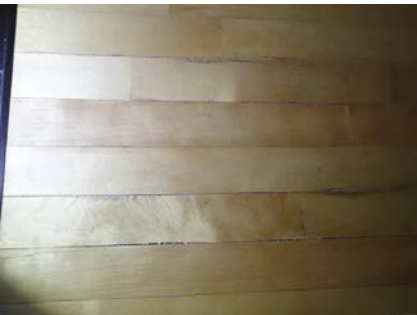
Sprekker i benkeplate.
