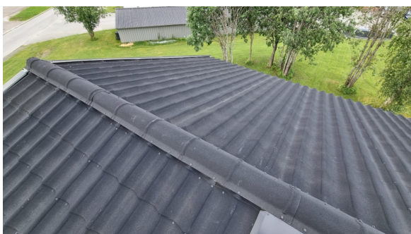
Visuell besiktelse av taket
