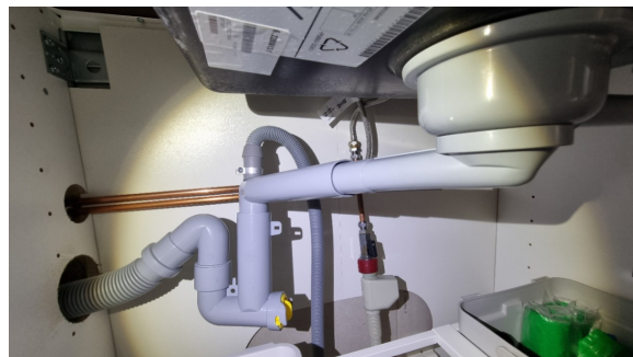
Kontroll av røropplegg under oppvaskkummen.
