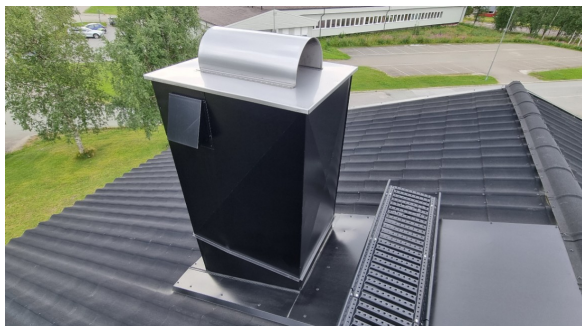
Kontroll av pipebeslag.
