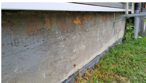
Kontroll av utvendige grunnmurer.
