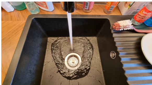
Kontroll av vanntrykk og avrenning.
