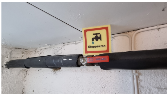
Kontroll av innvendig hovedstoppekran.
