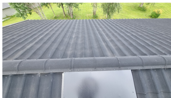
Visuell besiktelse av taket.
