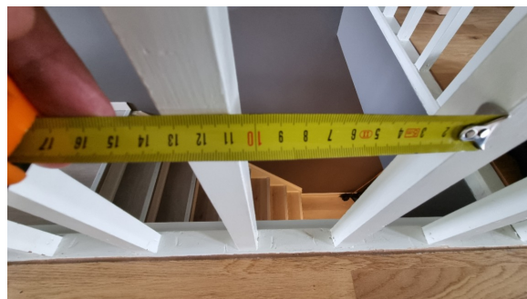
Måling av lysåpninger i rekkverk.
