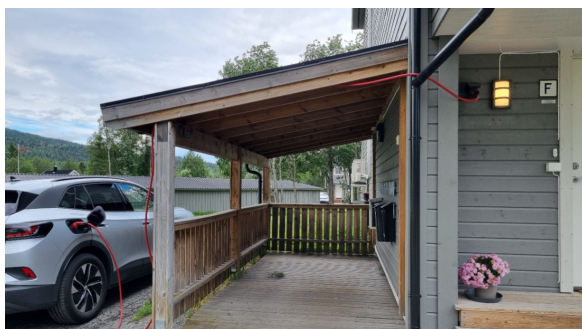
Takoverbygd postkassestativ like utenfor inngangsdøren.
