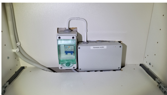
Teknisk kur i et av skrogene på kjøkkenet.
