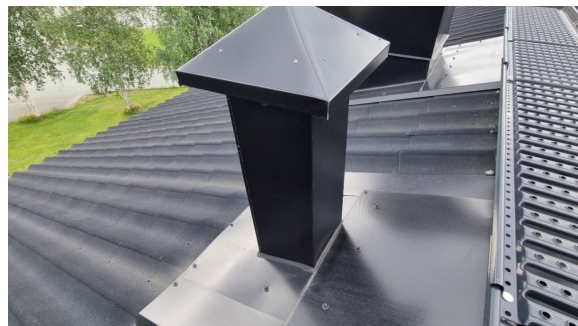
Kontroll av luftehatt
