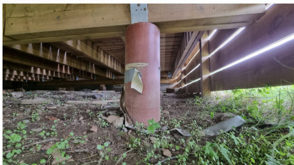
Kontroll av fundamenteringen under terrassen.
