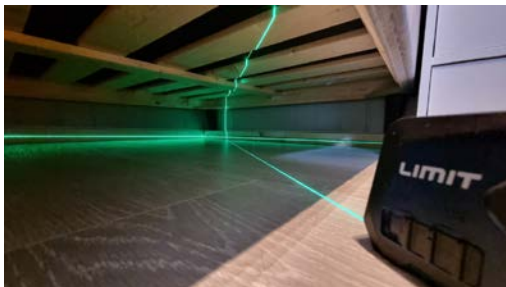
Kontroll av planavvik og skjevheter med krysslaser, her fra det minste soverommet i 1. etasje.
