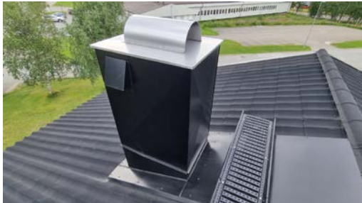
Kontroll av pipebeslag.
