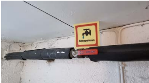
Kontroll av innvendig hovedstoppekran.
