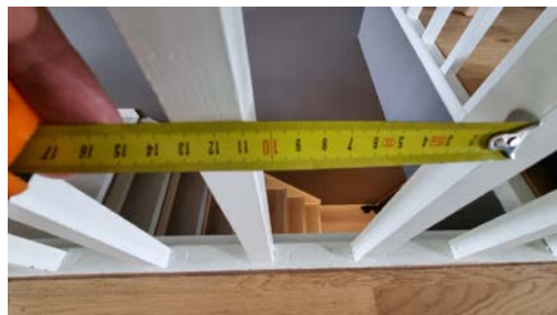
Måling av lysåpninger i rekkverk.
