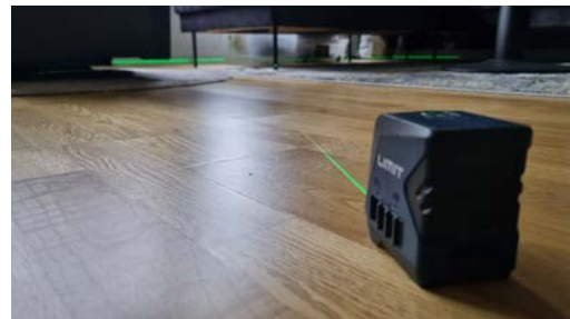
Kontroll av planavvik og skjevheter med krysslaser, her fra stuen i 2. etasje.
