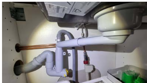
Kontroll av røropplegg under oppvaskkummen.
