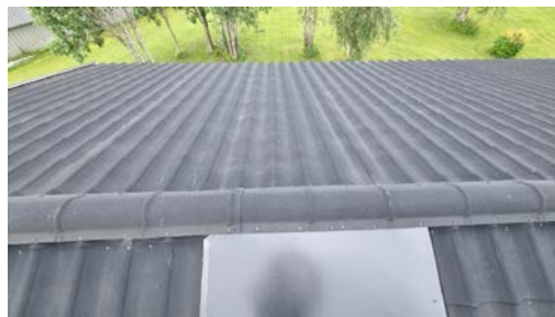
Visuell besiktelse av taket.
