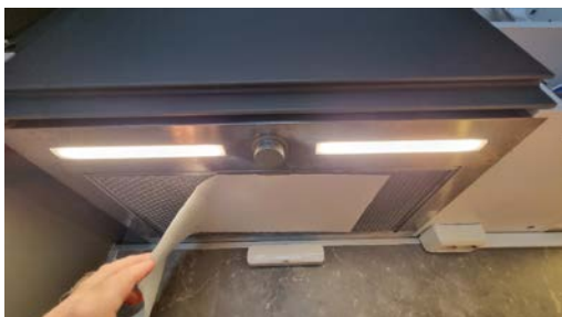
Funksjonstesting av det mekaniske avtrekket over koketoppen.
