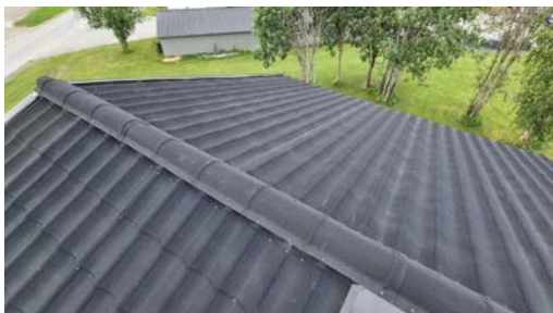
Visuell besiktelse av taket
