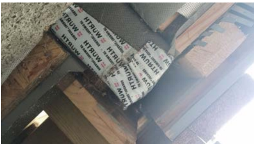
Kontroll av ytterkledningen og bakenforliggende lekter og vindsperre.
