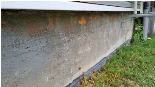
Kontroll av utvendige grunnmur.
