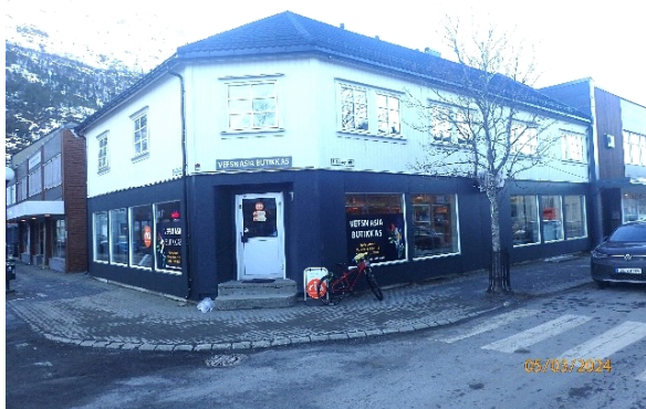
Fasade mot sørøst (butikkinnang).
