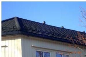
Taktekke av Decra og snøfangere på taksider mot front/gater.
