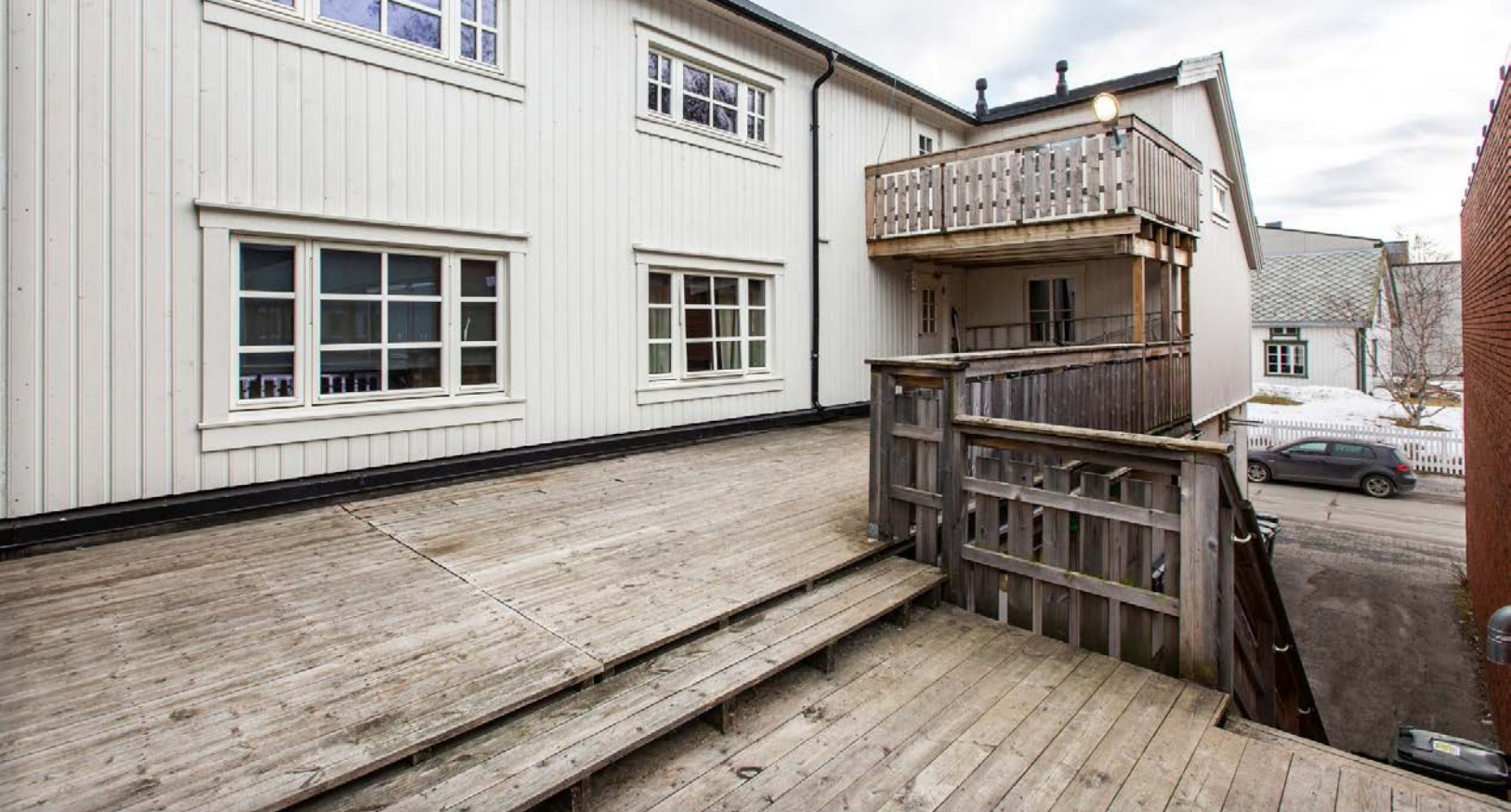
Trapp opp til hybler og utleieleiligheter i 2 og 3.etg.
