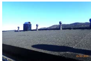
Taktekke av papp på bakre taksider.
