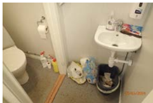
Toalett i næringsdel/butikk 1. etg.
