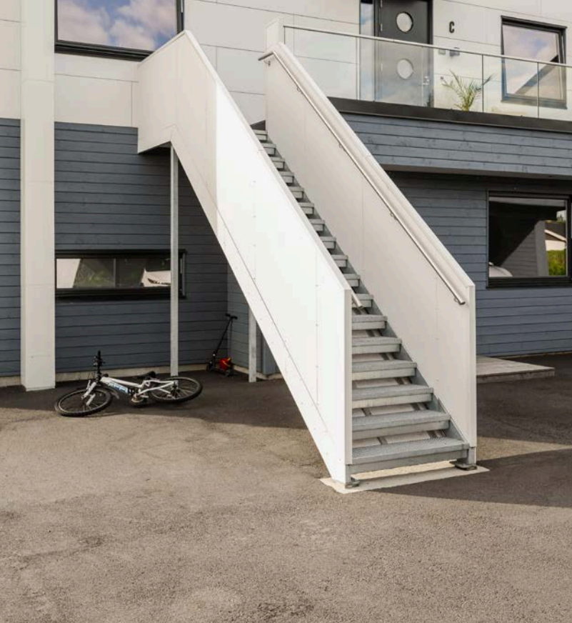
Egen trapp opp til privat inngangsparti i byggets 2. etasje,
