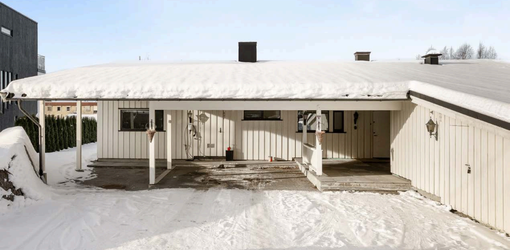
Utvendig adgang til 3 boder (teknisk rom på 3m 2 , bod på 6m 2 og lagerrom 15m 2 ).
