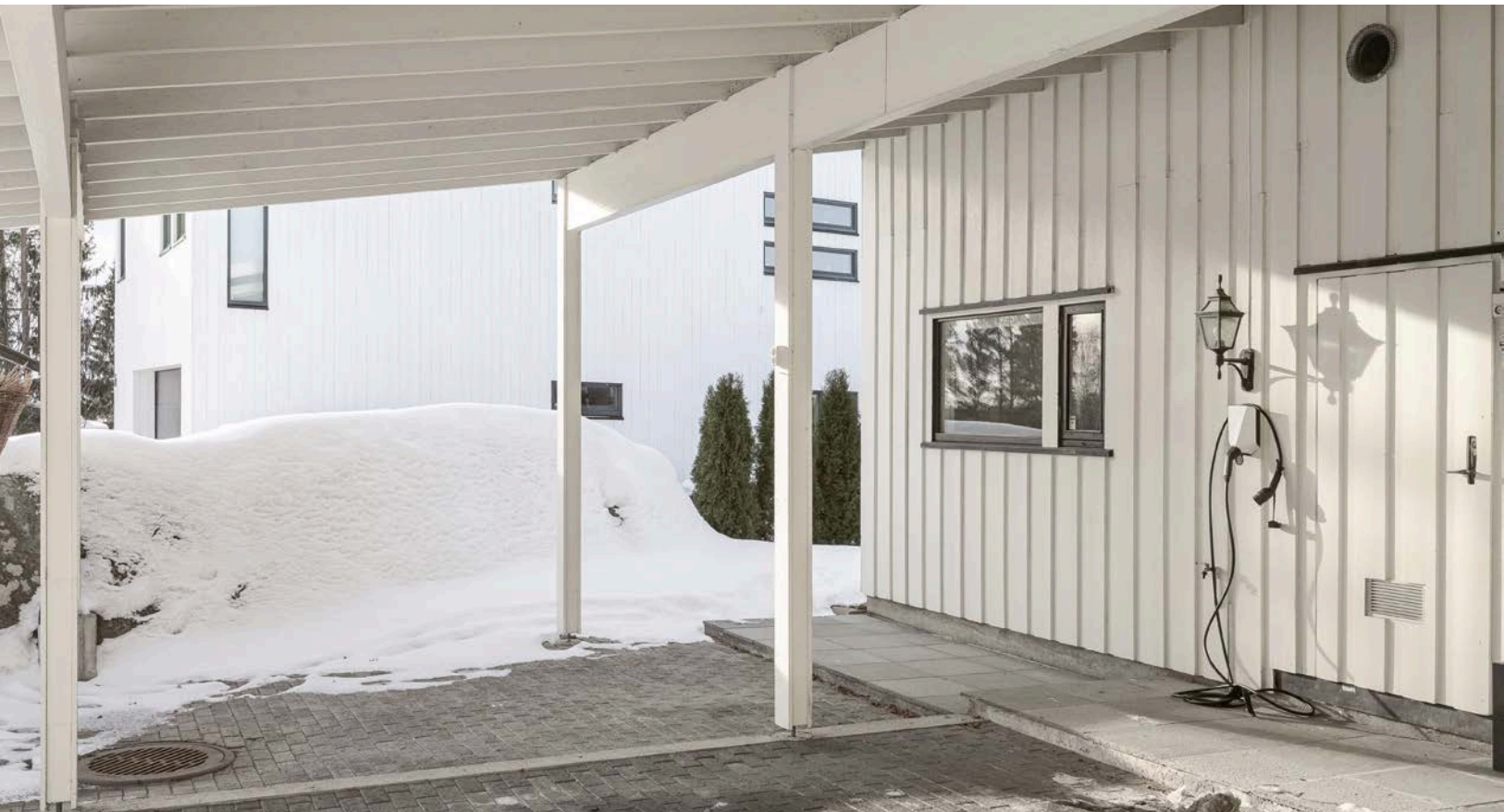
Boligen har også carport på ca. 62m 2 med elbil-lader.
