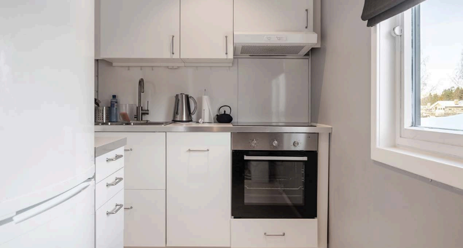
Lys kjøkkeninnredning fra Ikea som var ny i 2018. Innredningen har hvite glatte fronter og laminert benkeplate med nedfelt oppvaskkum. Integriert oppvaskmaskin, koketopp og stekeovn. Kjøkkenventilator med avtrekk ut.
