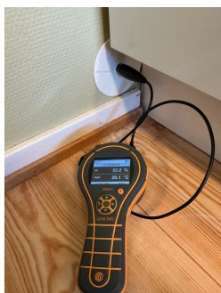
Bilde fra fuktmåling i veggkonstruksjon.
