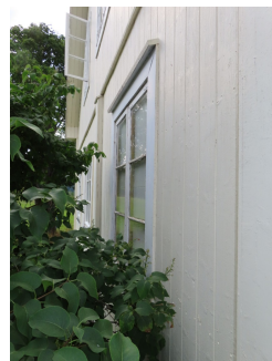
Ett eldre vindu. Vinduet er isolert og kledd igjen på innsiden.
