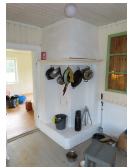
Tidligere åpen gruepeis som gjenmurt i forbindelse med foringen av pipen. Sotluke.
