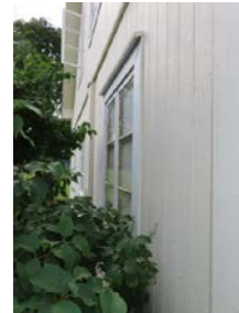
Ett eldre vindu. Vinduet er isolert og kledd igjen på innsiden.
