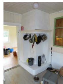
Tidligere åpen gruepeis som gjenmurt i forbindelse med foringen av pipen. Sotluke.
