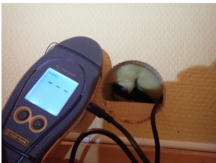
Ingen symptomer på skadelig fukt i hulltakingen
