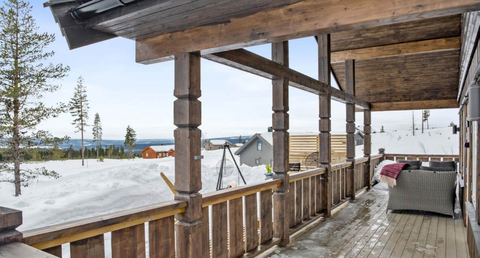
Den midterste delen av terrassen som vender mot syd er overbygget. Terrassen har impregnerte terrassebord på gulv og beiset- malt rekkverk.
