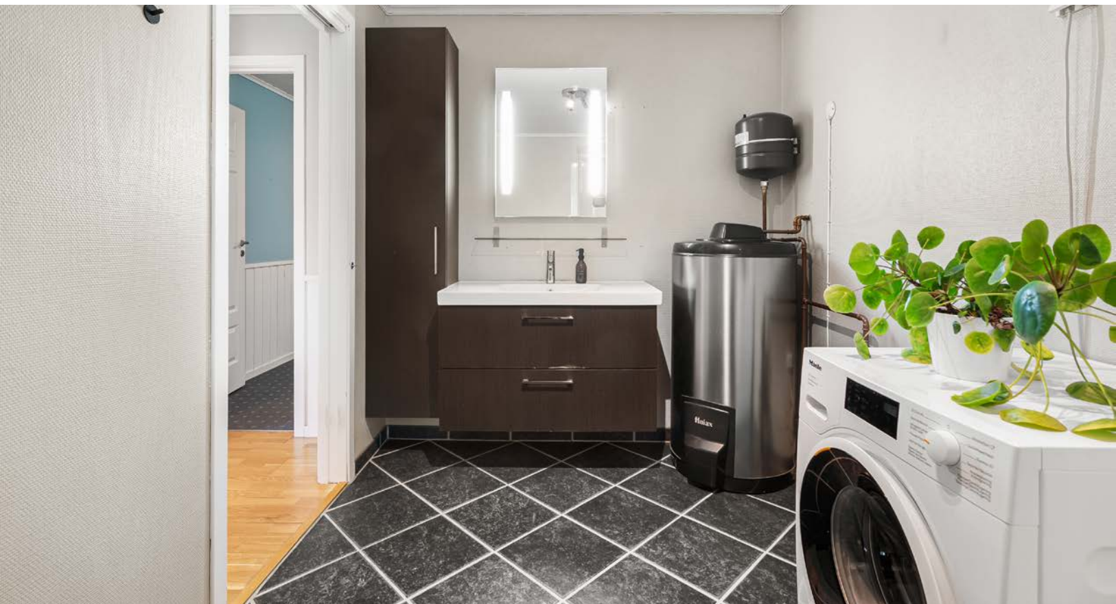
Kombinert bad/vaskerom med fliser på gulv.
