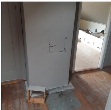
Feieluke på loft og kjeller
