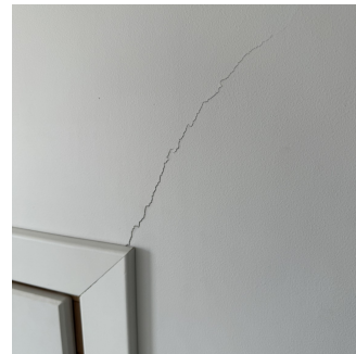
Riss i overflate i gang på loft
