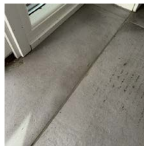
Riss i overflate i gang på loft
