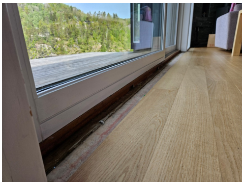
Terskel til terrassedør er fjernet
