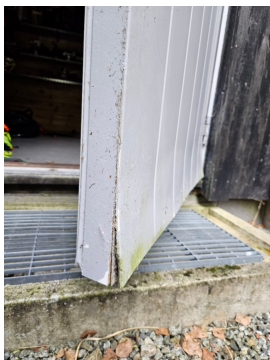
Nedre del av dørbladet til boden sveller
