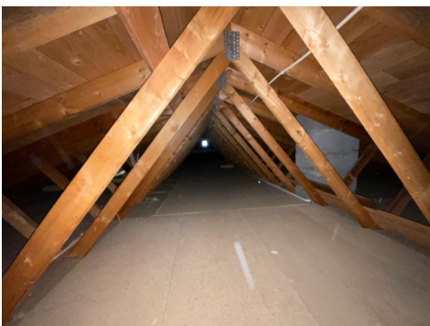
Fuktmåling og skolder i undertaket på loftet
