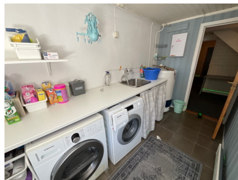
Bereider i hjørnet på vaskerommet
