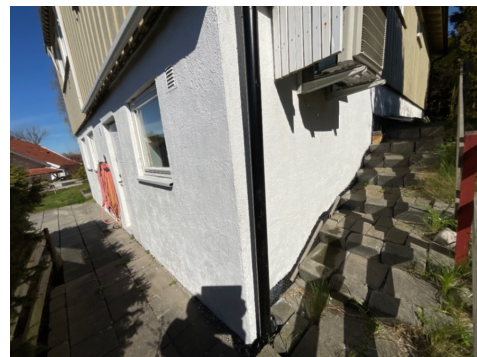
Grunnmur på ytterhjørnet
