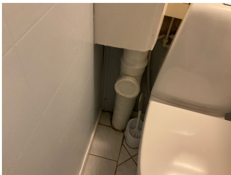
Avløpsrør på badrom i kjelleren
