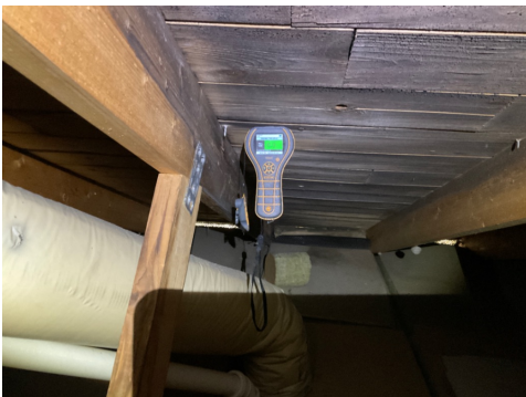
Fuktmåling og skolder i undertaket på loftet
