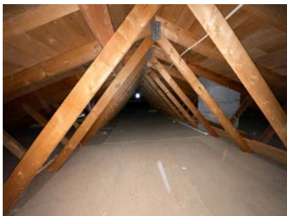
Fuktmåling og skolder i undertaket på loftet
