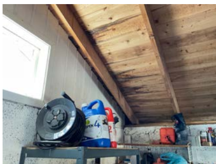
Undertak i garasjen
