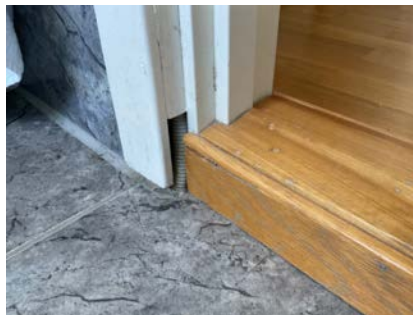
Eikelist og el-rør ved døren
