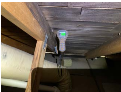
Fuktmåling og skolder i undertaket på loftet
