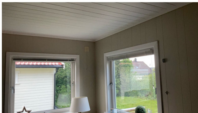
Ventiler i vegg.
