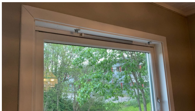
Ventiler i vindu.
