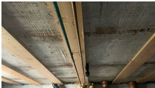
Vannledning av kobber.
