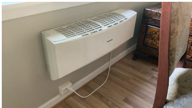
Luft til luft varmepumpe.
