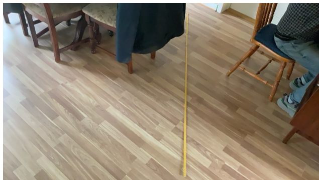
Meterstokk viser hvor avvik er registrert.
