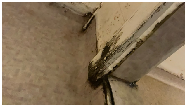
Fuktskader på våtrom.
