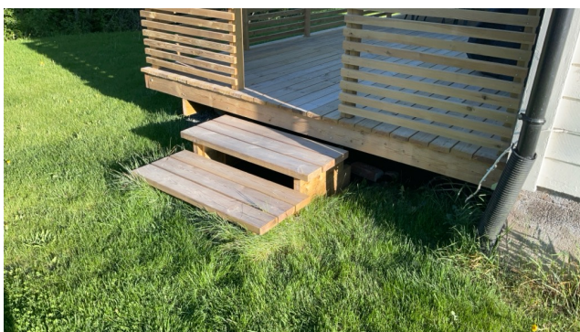
Trapp opp til terrasse.
