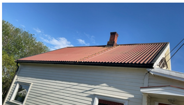
Taktekking av bølgeblekkplater.
