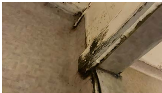
Fuktskader på våtrom.
