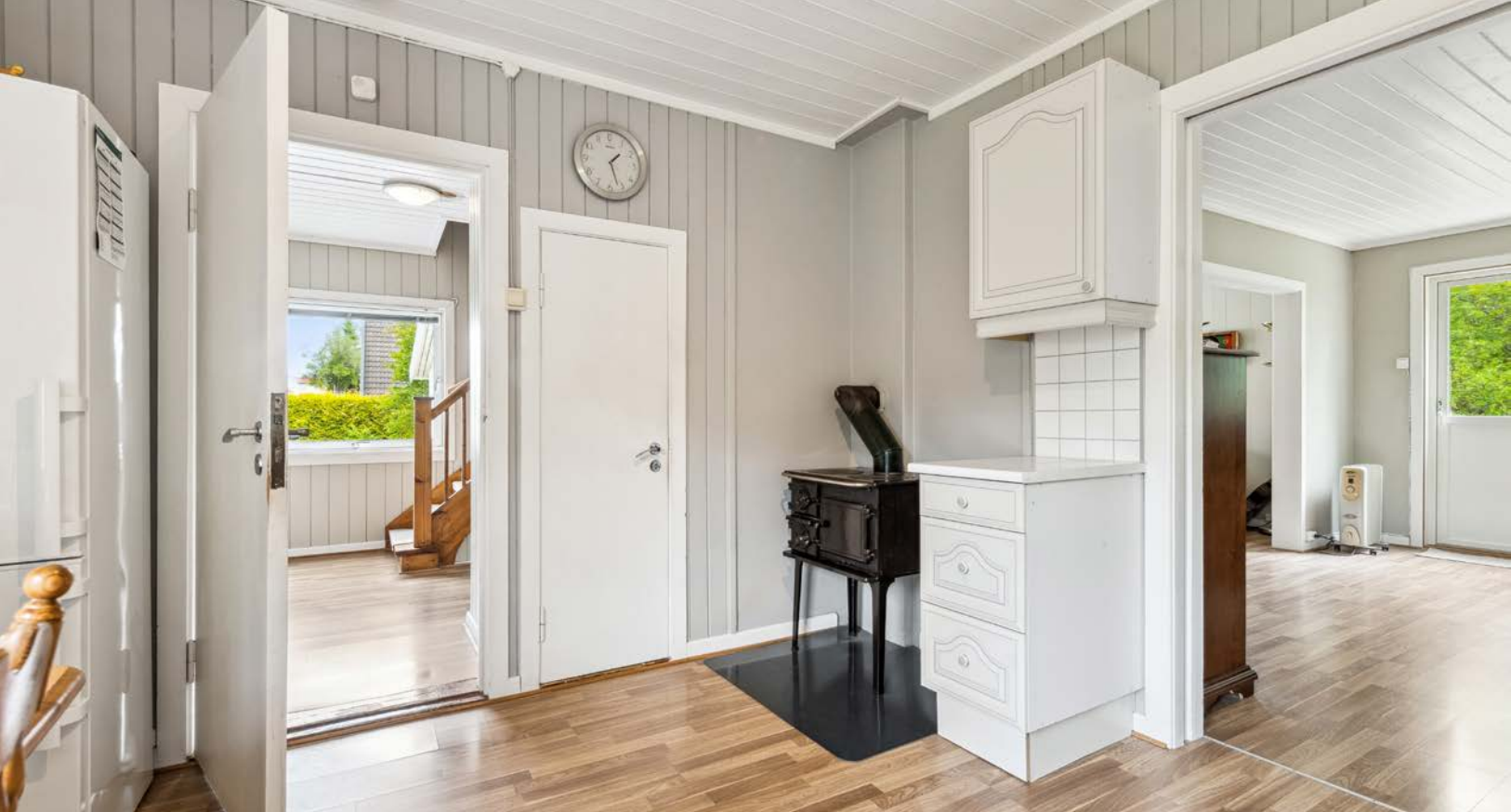
Eldre vedfyrt ovn på kjøkken.
