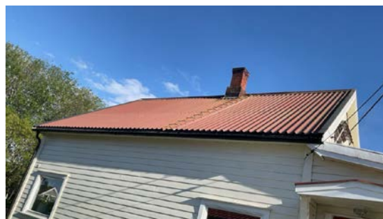
Taktekking av bølgeblekkplater.
