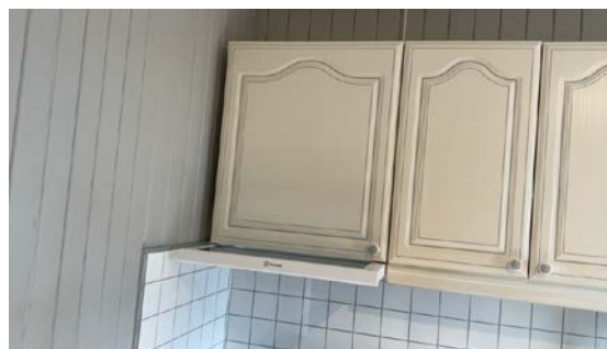
Kjøkkenventilator med avtrekk ut.
