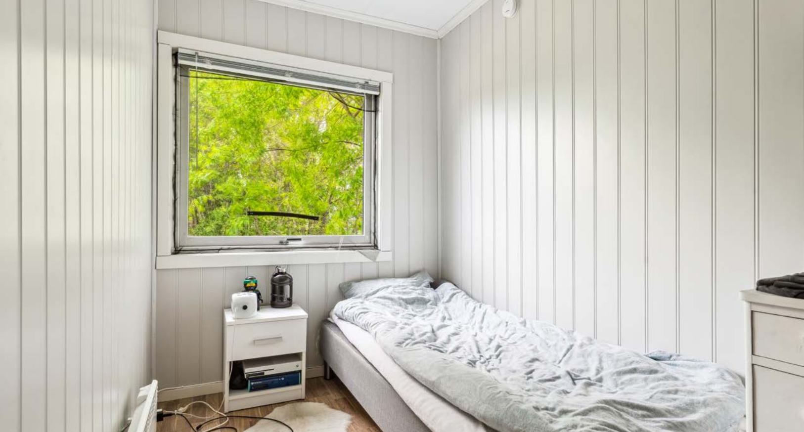
Tidligere glassveranda innredet til gjesterom. Det er ikke søkt om bruksendring (ikke godkjent soverom)
