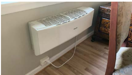
Luft til luft varmepumpe.
