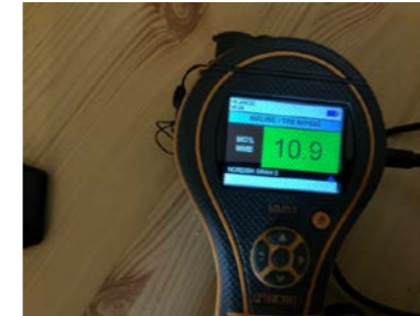
Måling i treverk. Målinger er foretatt uten å påvise unormale forhold.
