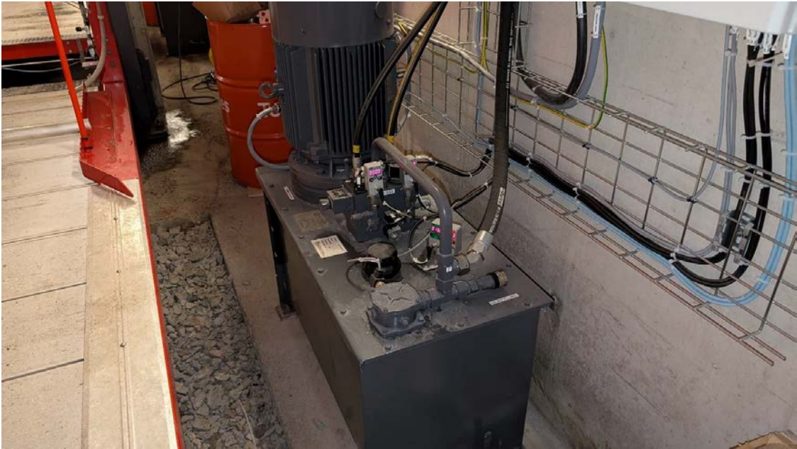
Foto 31: Hydraulikk-aggregatet, ingen dryppekar
