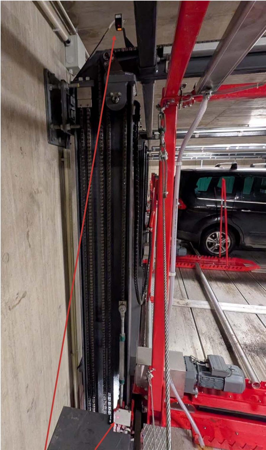
Foto 40: Avstandsmåler og målepunkt for høyde på løft i hjørnet på ramme
