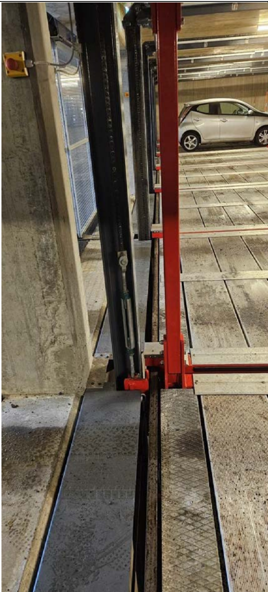
Foto 65: Spalte fra fem til en halv centimeter
