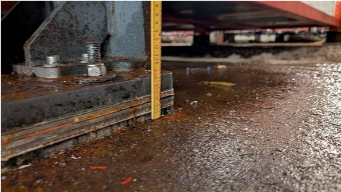
Foto 15: Demping mellom plate og bolteforbindelse
