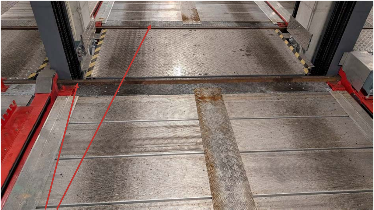
Foto 42: Skinne/bjelke horisontal forflytning, øvre nivå
