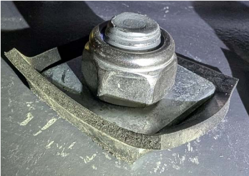
Foto 19: Komprimert gummi i forbindelse, BK1
