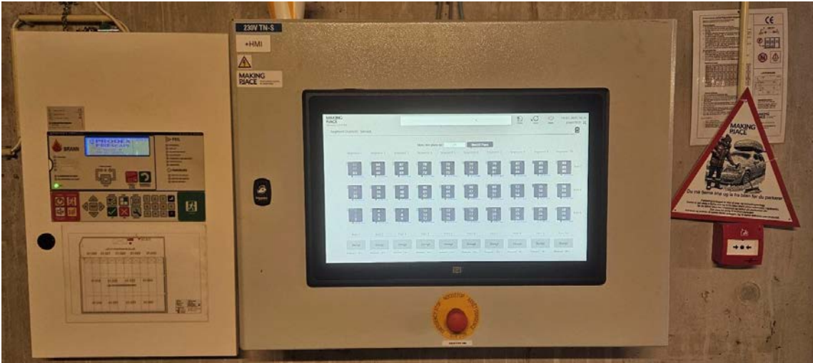
Foto 12: Styrepanel p-anlegg
