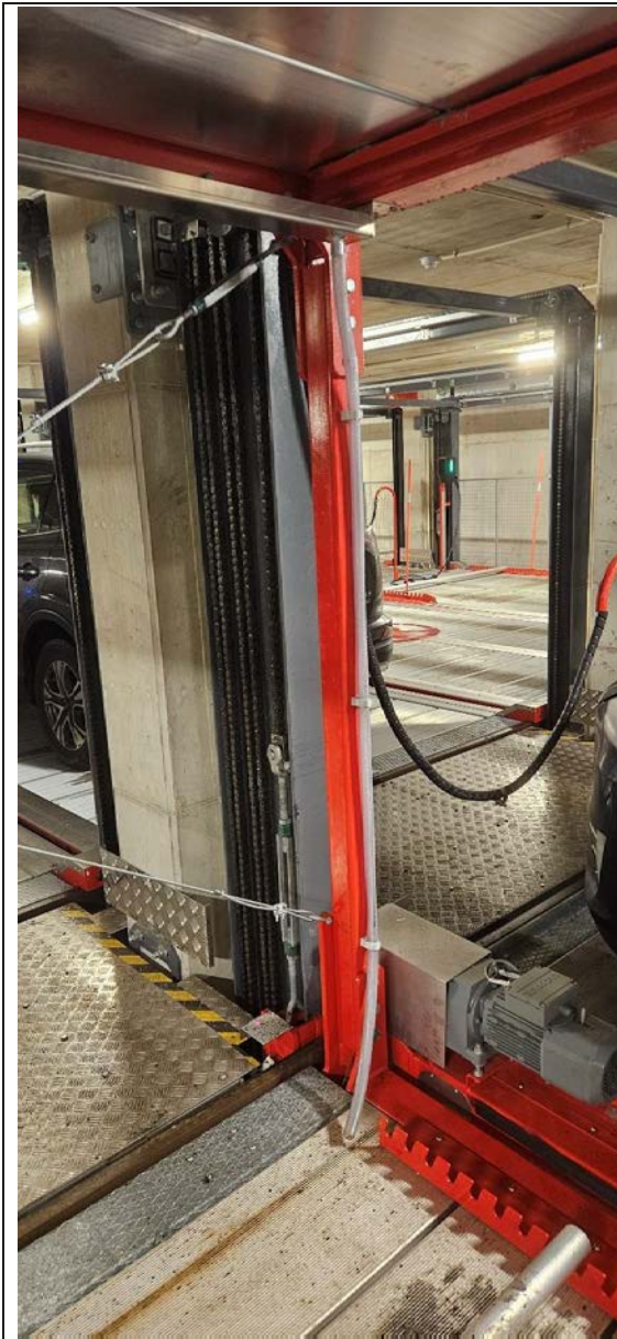
Foto 64: Avløp fra plattform over
