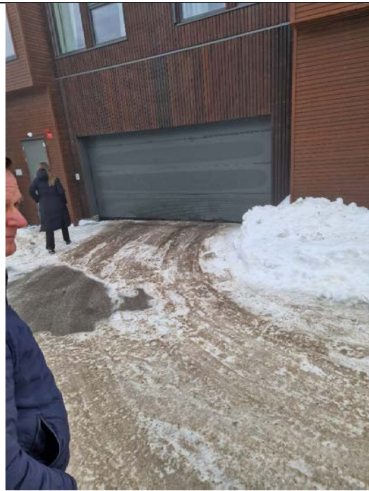
Foto 8: Uteområdet Tyttebærtråkket, innkjøring garasje BK1, Hus L.
