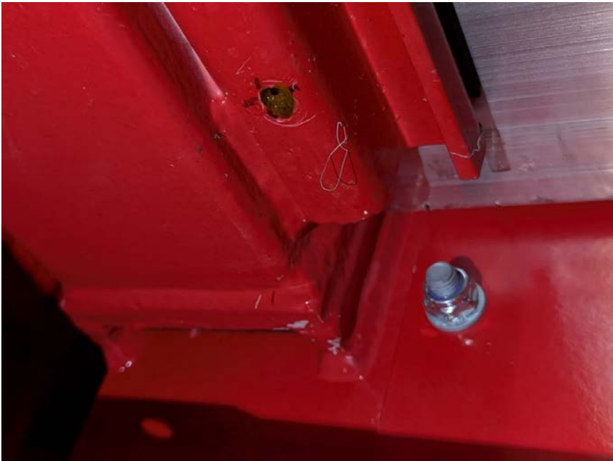
Foto 34: Hull for drenering over renne i plattformen
