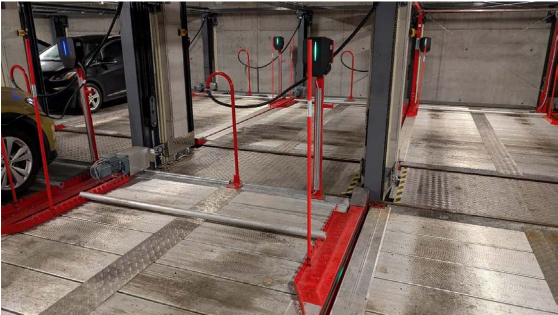
Foto 32: Kjøreplattform øvre nivå, BK2
