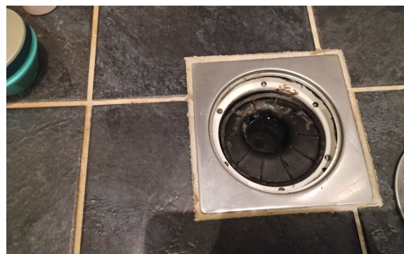
Sluk i dusjsonen
