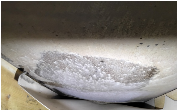
Bilde av undertak på loftet
