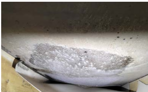
Bilde av undertak på loftet
