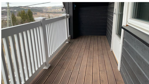
Terrasse i 2. etg. Rekkverk i plast.
