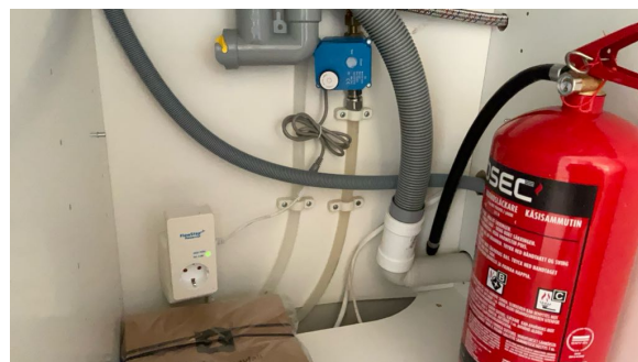
Vannstoppersystem med sensorer er montert.
