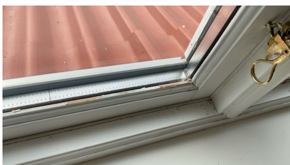
Slitasje reg på vinduer i 2. etg.
