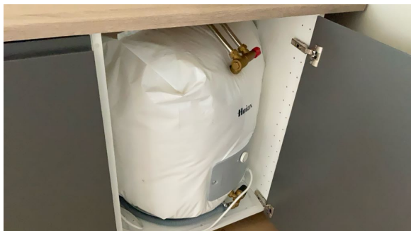
120 liter bereder i kjøkkenbenk i hybelleilighet.
