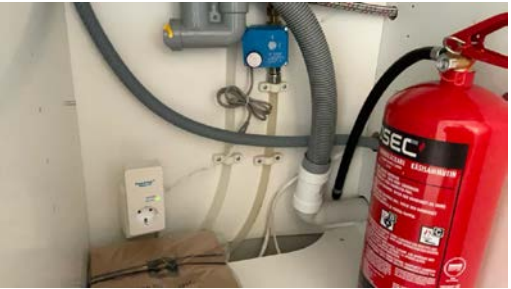
Vannstoppersystem med sensorer er montert.
