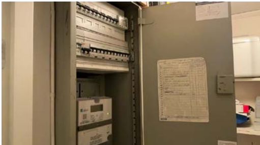
Skap i 1. etg. plassert i bod.
