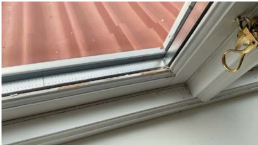
Slitasje reg på vinduer i 2. etg.
