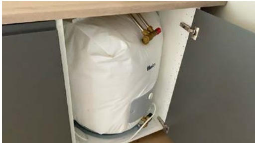
120 liter bereder i kjøkkenbenk i hybelleilighet.
