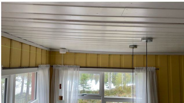
Eksempel på store skjevheter i himling ved måling med laser.
