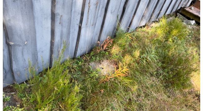
Eksempel på at bordkledning delvis går helt ned til terreng.
