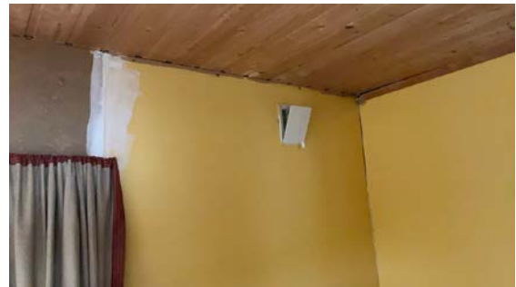
Eksempel på gjenstående arbeider.
