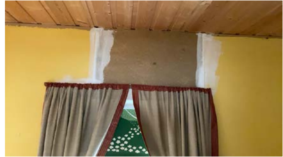
Eksempel på gjenstående arbeider.
