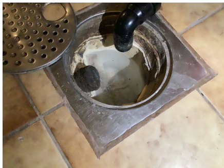
Ikke tegn til membran rundt sluk.
