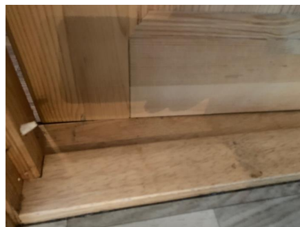
Soveromsdøren trenger justering
