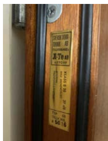
Brann- og lydklassifisert inngangsdør
