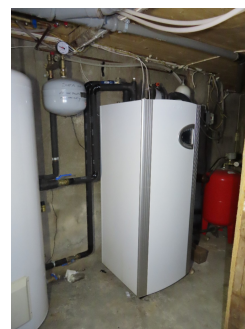
Vann til væske varmepumpe som leverandør av oppvarmet vann til vannbårent varmeanlegg i bygget.
