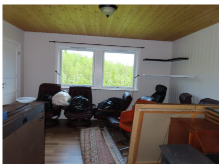
Del av innvendige overflater.
