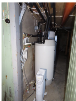
Kjellerplan med varmtvannsberedere samt åpent installert rørsystem for vannbåren varme.
