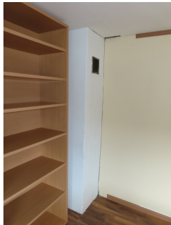
Pipe i 2.etg kledt inn med plater samt lettvegger.
