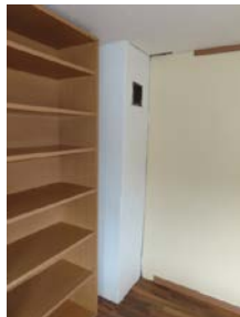
Pipe i 2.etg kledd inn med plater samt lettvegger.
