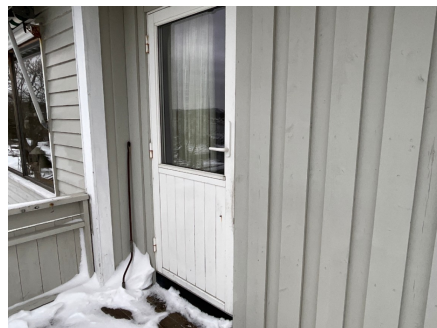
Nyere malt verandadør.
