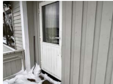
Nyere malt verandadør.
