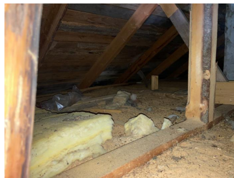
Møneloft over opprinnelig del.
