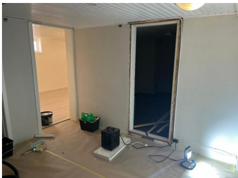
Pågående arbeider i kjeller.
