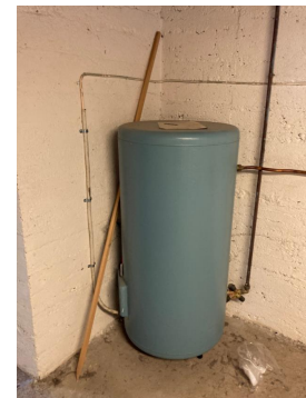
Varmtvannstank til begge boenheter.
