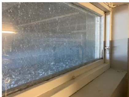
Koblet vindu med slitasje.
