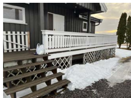
Manglende rekkverk.
