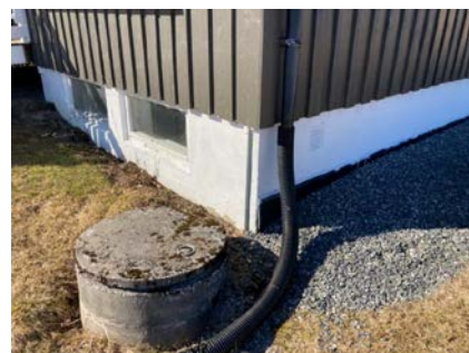
Synlig grunnmursplast mot øst.
