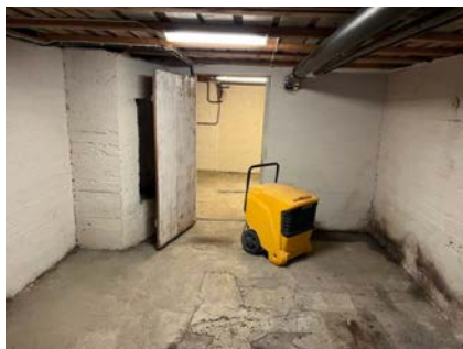
Pågående avfukting av kjeller på befaringstidspunktet i 2025.
