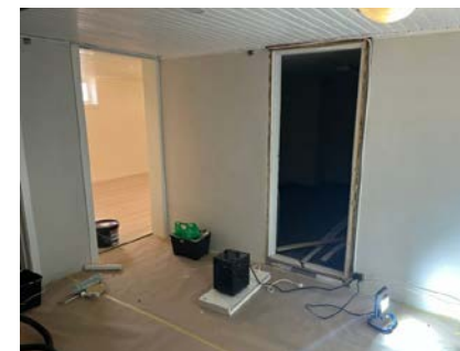
Pågående arbeider i kjeller.
