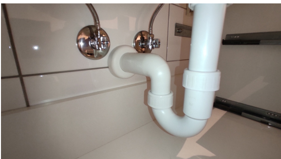
Kontroll av røropplegg.
