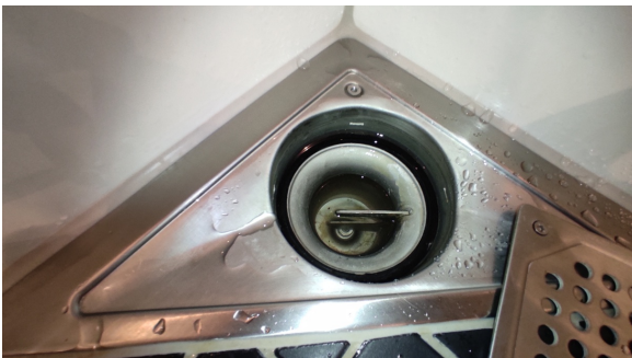
Kontroll av sluk.
